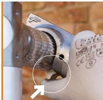
**Le traverse e i parapetti sono facili da montare e sganciare con i ganci a pressione.**
